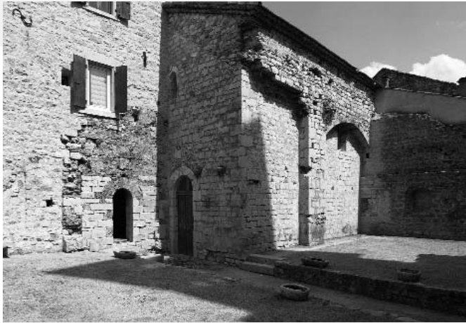
Dans l'enclos du prieuré, la chapelle N.-D. des Pommiers et, à gauche, la porte en plein cintre, probable vestige d'un bâtiment carolingien
