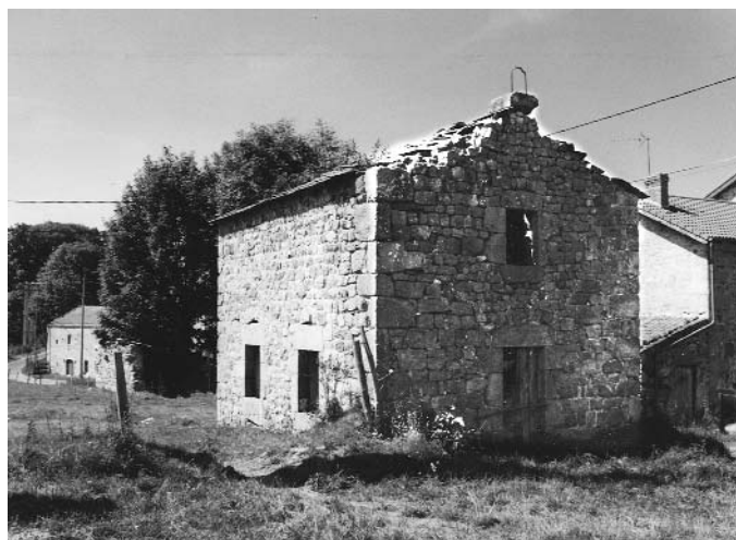
La maison de la Béate avant restauration
