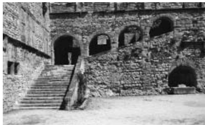
Grand escalier en berceau du château de La Voulte
