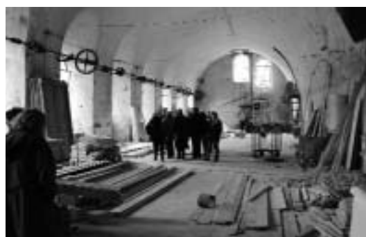
Grande salle du rez-de-chaussée
