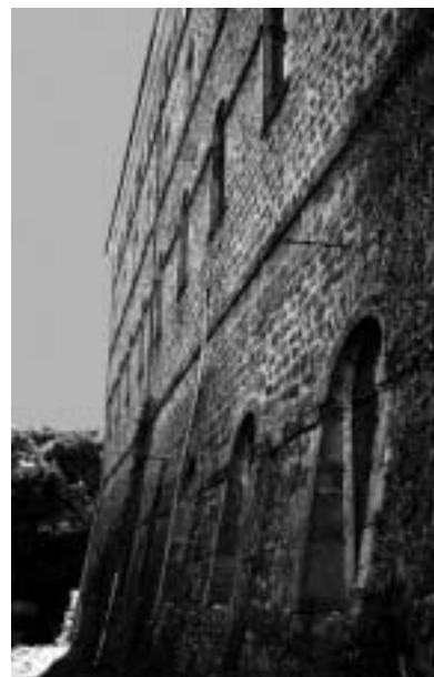
L'imposante façade de 4 étages
